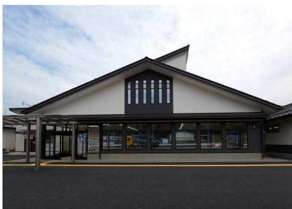
道の駅「たろう」新築工事
