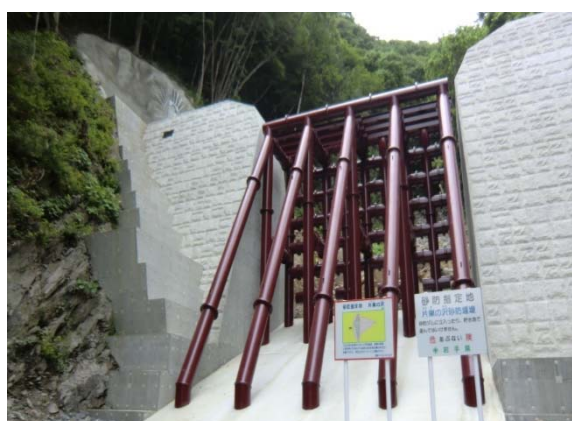
片巢の沢（2）筋箱石地区砂防堰堤工事
